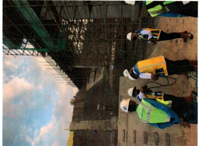
Pengukuran Scan Rebar Tulangan Beton dan pengukuran kuat tekan beton pada dinding Intake
